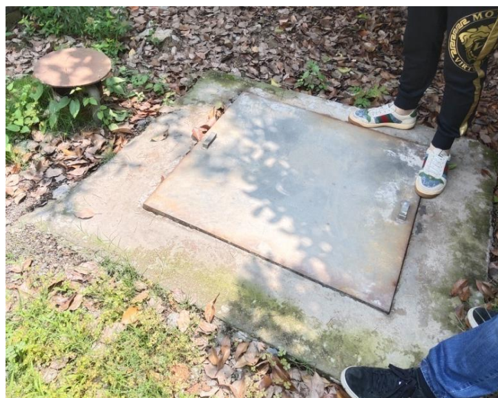
图 3.1-5 医院现有二号污水处理站排污口
