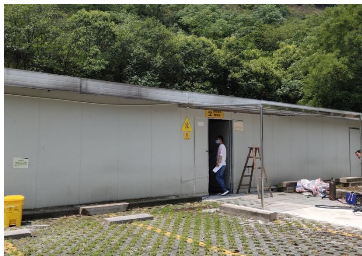
图 3.1-6 医院现有医疗废物间外部
